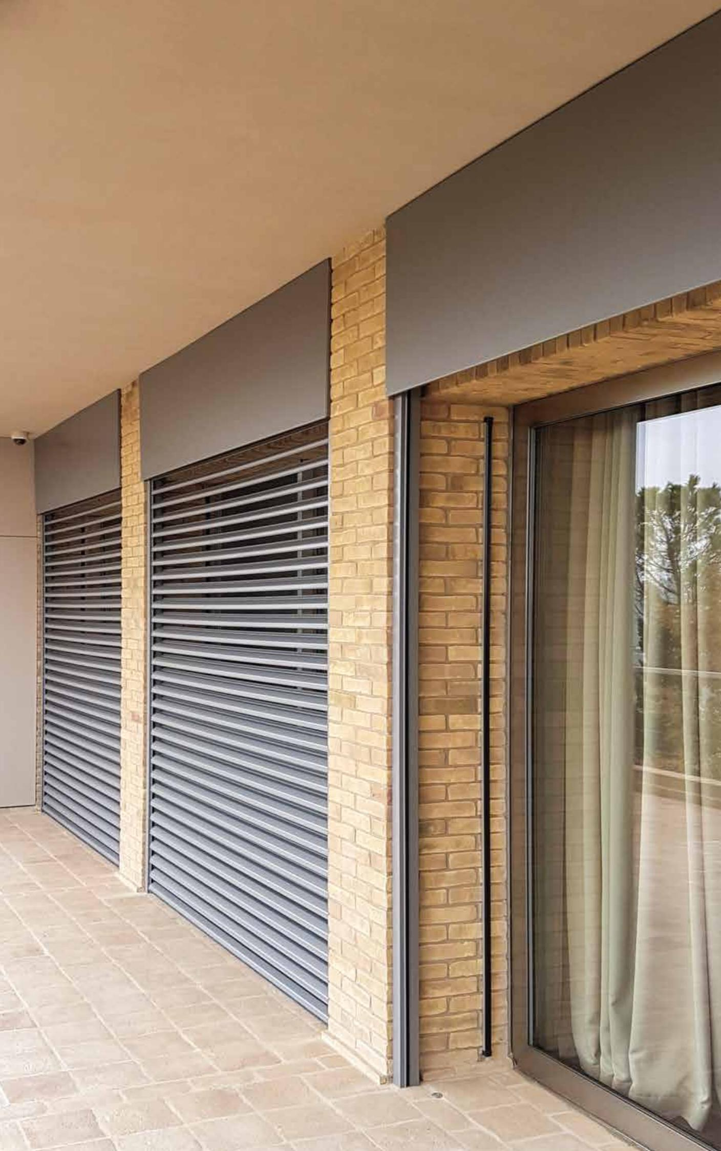
Con questo elemento architettonico, una volta chiuse le lame orientabili, si crea una doppia parete con un vuoto convettore interno il quale, attraverso lo spostamento delle masse d'aria, permette di mantenere nell'edificio una temperatura interna mite, raggiungendo un ottimo efficientamento energetico
