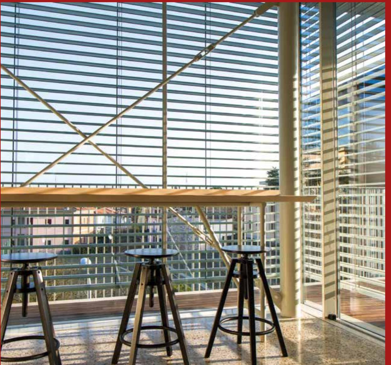
Per questo progetto con stile industriale è stato scelto il sistema a filo da 90mm con guide laterali a cavo, indicate per chi ama soluzioni minimal e non vuole rinunciare alla massima visibilità che offre un'ampia superficie di vetro
