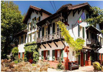
Albergo Quattro Fontane (4*) Via Quattro Fontane, 16 30124 Lido di Venezia (VE) www.quattrofontane.com info@quattrofontane.com 041 5260227
